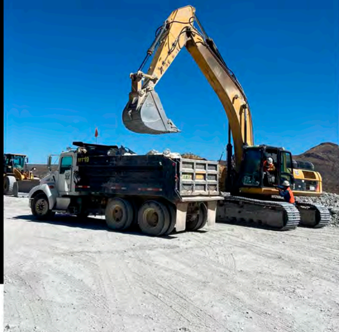
Carga de material con Retroexcavadora.
