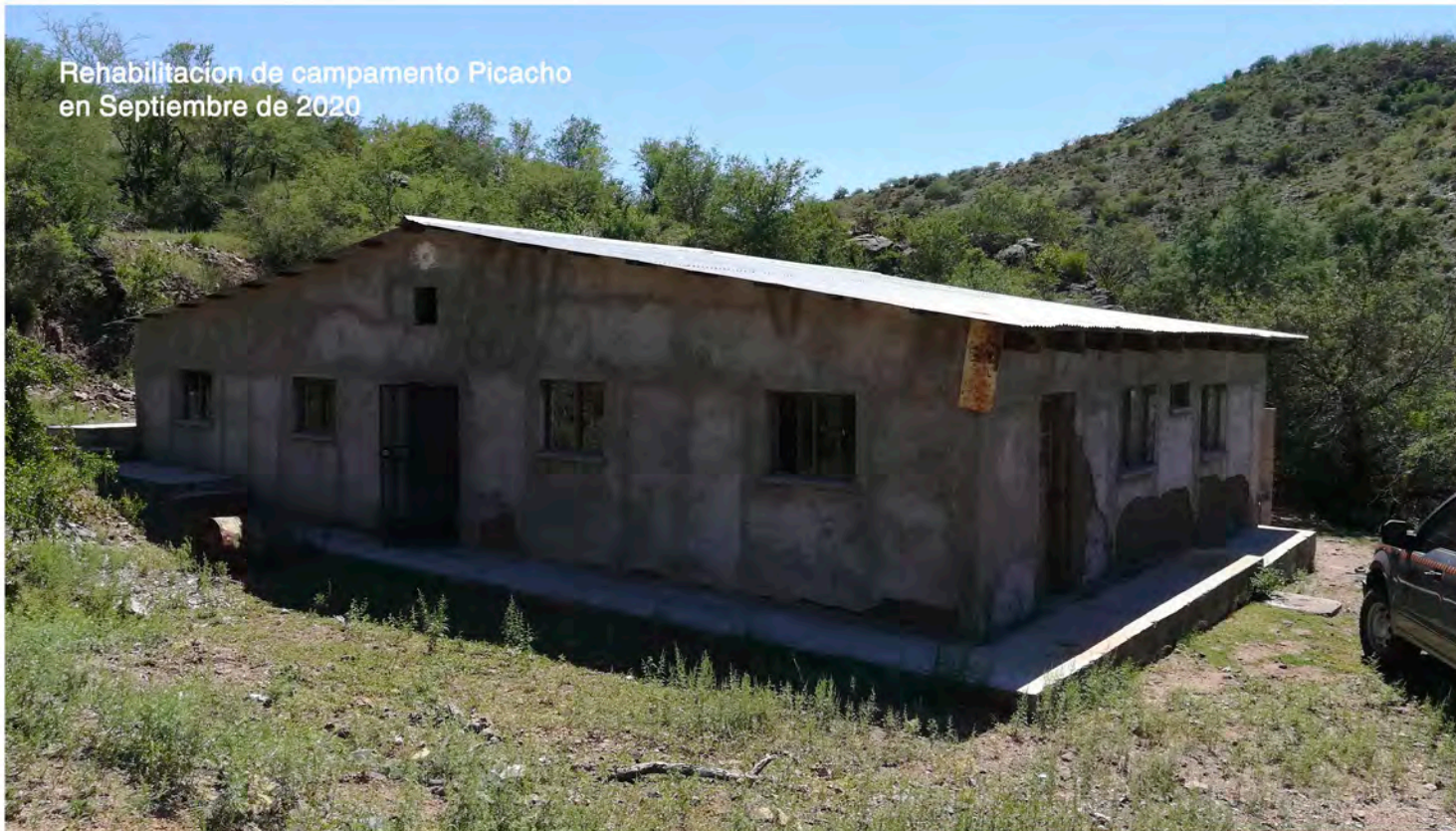
Rehabilitación de campamento Picacho en Septiembre de 2020
