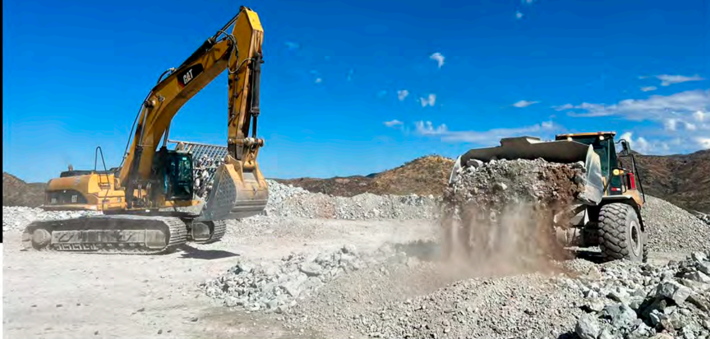
Rehabilitación de caminos con tractor.
